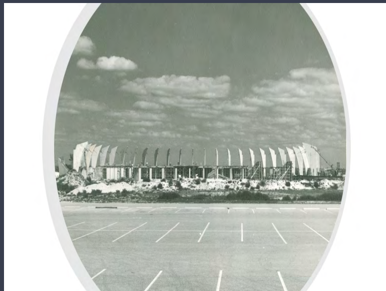
Comienzo de la estructura.
