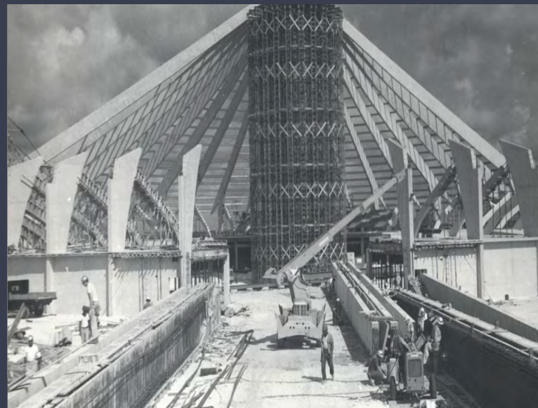
Columna de apoyo para la cúpula
