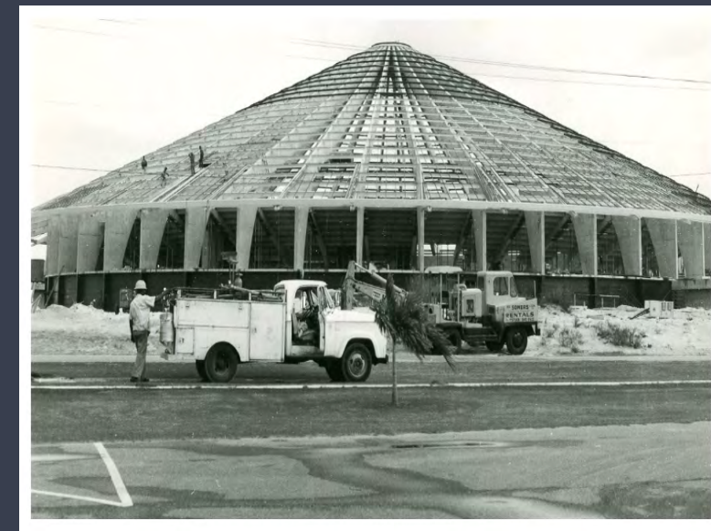
Estructura de refuerzo para el concreto.
